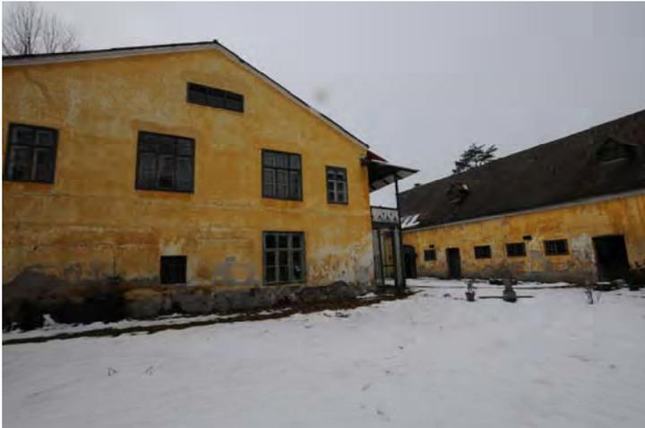
Das Gebäude ist massiv in Mischbauweise auf Streifenfundamenten errichtet. Es teilt sich in ein Wohngebäude, einem Stallgebäude und Garagen. Die Fenster sind Holzkastenstockfenster. Das Dach ist unterschiedlich gedeckt, teilweise aus Welleternit, teilweise mit Ziegeln, teilweise mit Rhombuseternitplatten. Vor dem Eingangsbereich der herrschaftlichen Wohnung befinden sich zwei Steinfiguren. Die Fassade ist verputzt und mineralisch gestrichen. Im Hofbereich ist ein Teil mit Wärmeschutz versehen.
